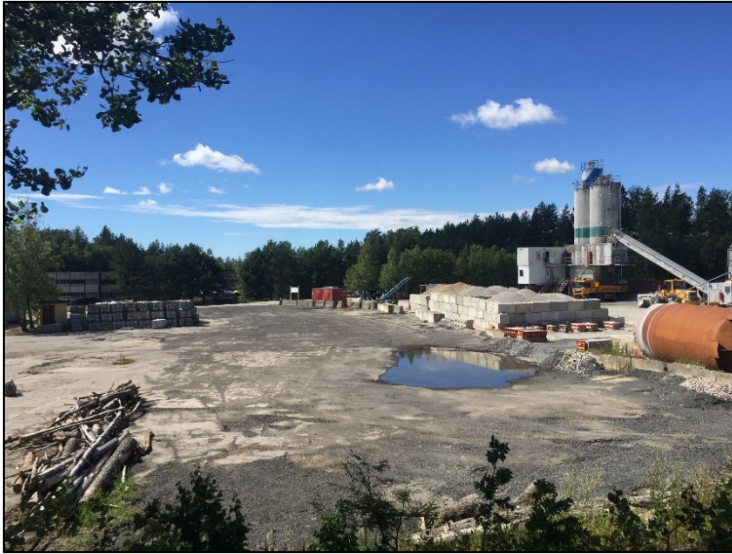
Figur 8 Bildet er tatt fra Gamle Kongevei mot sørvest. Betongverket til høyre. (Sweco Norge AS, 2016)
