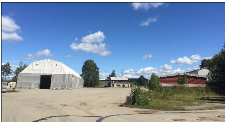
Figur 10 Bildet viser lager/verksted (rødt bygg) og plashall nordøst på eiendommen. Plashallen er nå fjernet. Rett frem er et kontorbygg. Skjult bak lagerbygget er et par mindre garasjer. Den søndre fasaden (hvit) på den den midlertidige boliggriggen vises så vidt på bildet. (Sweco Norge AS, 2016)
