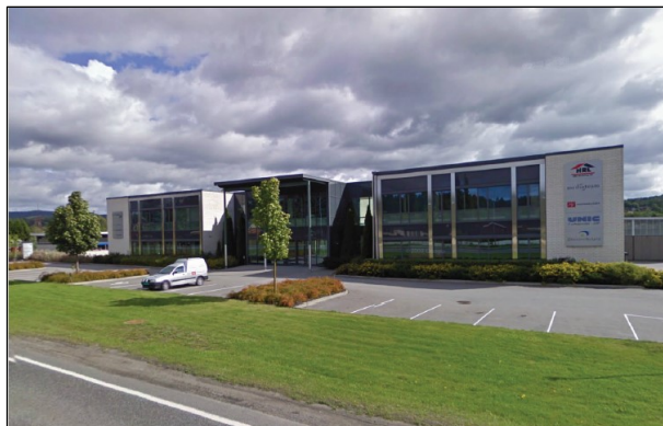
Figur 5.13: Lange fasader som visuelt er oppbrutt, virker mindre dominerende.
